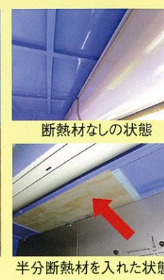
天井へ50mmの断熱材施工(オプション)
